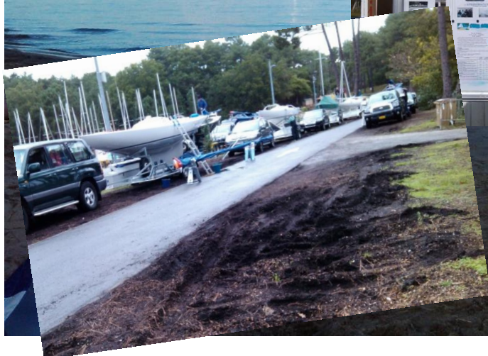
Ornières sur parking faites par des véhicules lourds
