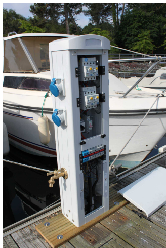
Nouvelles bordes électriques sur les pontons (attention nvelle prise de branchement élect. et eau à se procurer)
