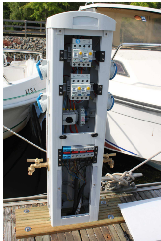
Nouvelles bordes électriques sur les pontons (attention nvelle prise de branchement élect. et eau à se procurer)
