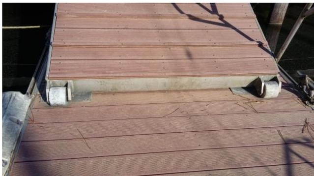
Ponton E, l'emplacement de la plaque de roulement est décalé.
