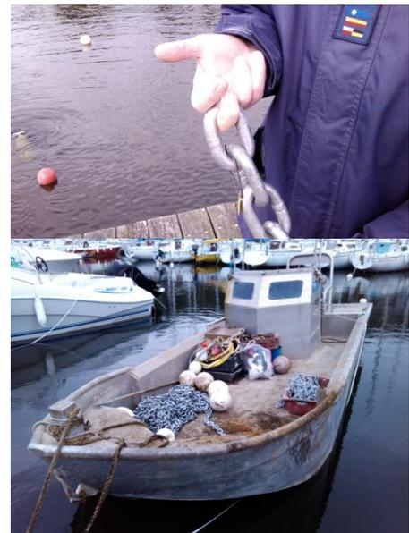
Remplacement de la chaîne mère et des chaînes filles de la traque D pair avec pendilles et sans bouée de mouillage
