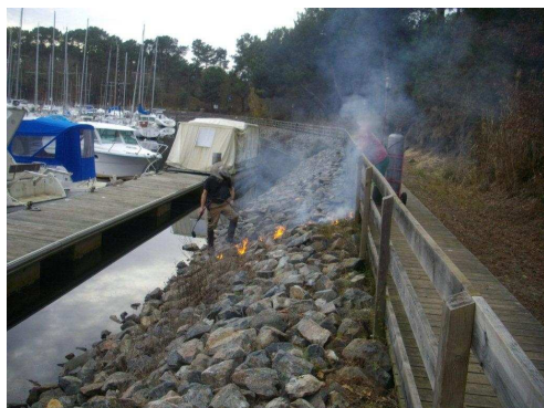
Brulage et faucardage des herbes sur l'enrochement autour de la halte nautique
